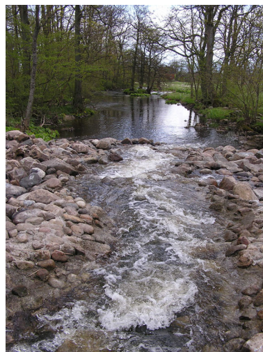
Figur 14. Vid kvarndämet i Vollsjö, Sjöbo kommun, har en fiskväg anlagts.
