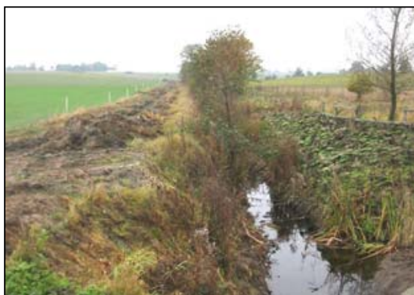
Figur 12. För att dränera ut detta flacka område, söder om Bjärsjölagård i Sjöbo kommun, har ett ca 3 m djupt dike grävts. En höjning av vattenytan upp till marknivå påverkar mycket stora områden.
