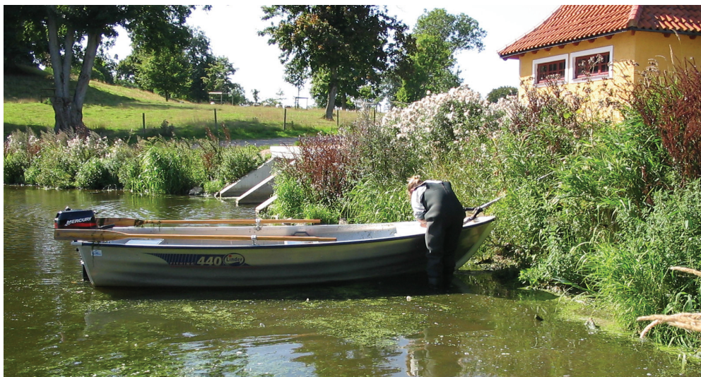
Figur 4. Näsbyholmssjön – inloppet vid pumpstationen..
